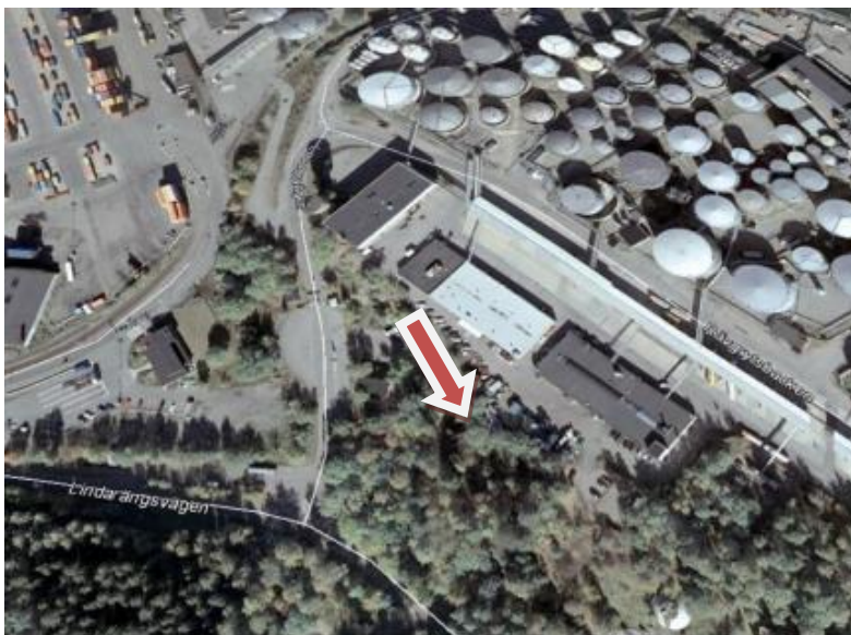
Bild 13.7 Loudden med befintlig tunnelmynning
