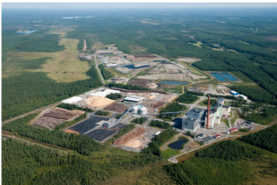
Figur 4.3:7 Dåva industriområde, ca 5 km norr om Umeå, har stor potential att utvecklas med järnvägsanslutning. Området är mycket transportintensivt.
