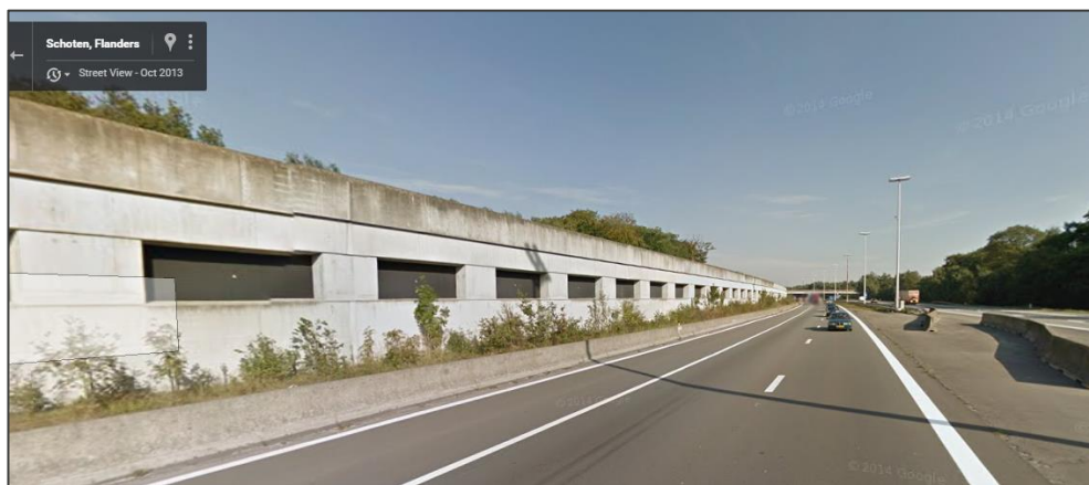
Figur 7-10 Tågtunnel i kommunen Schoten
